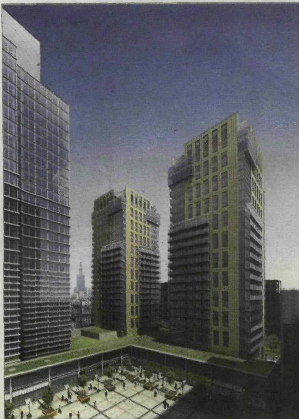
W Platinum Towers przy ul. Grzybowskiej metr apartamentu na ostatnim piętrze kosztuje 22 tysiące złotych
